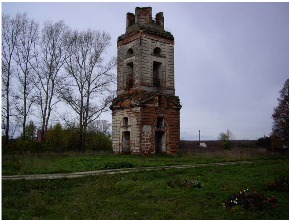
Разрушенная колокольня и дорога через Храм на охотхозяйство
